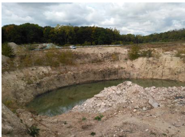
Vue du Terrain des essences après démantèlement des cuves d'hydrocarbures
